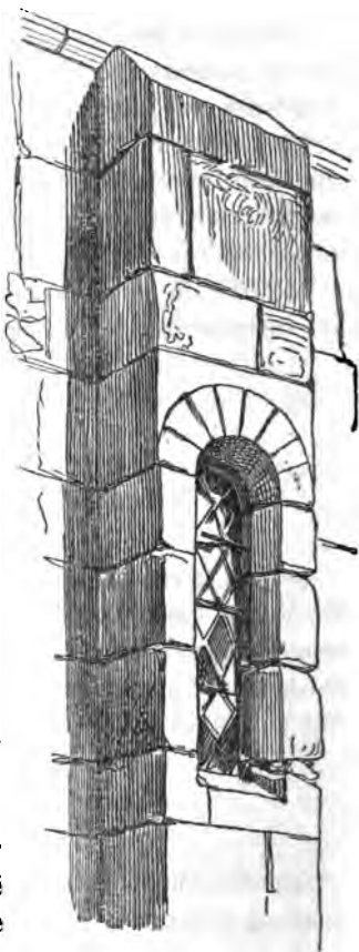
UN DES CONTREFORTS DE L'ÉGLISE ST.-LAURENT, PERCÉ D'UNE FENÊTRE.
